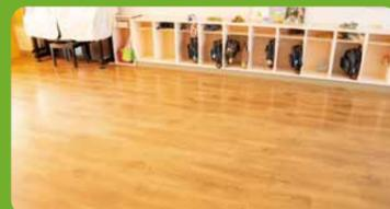
2階の年長2教室はベルギー産の針葉樹を使い、衝撃に強く、床下にクッション材が入っています。1階の5教室はリズム室と同じアリーナ専用の素材を使用しています。
